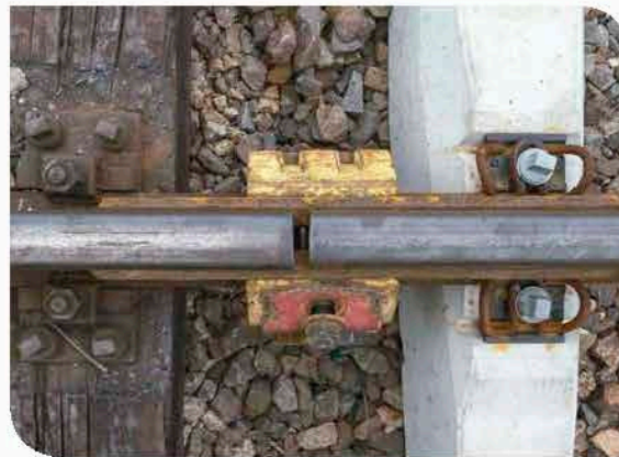
Figura 2.26. ¿Sabías que cuando se colocan los rieles en las vías del tren nunca se unen totalmente? ¿Cuál crees que sea la razón?
